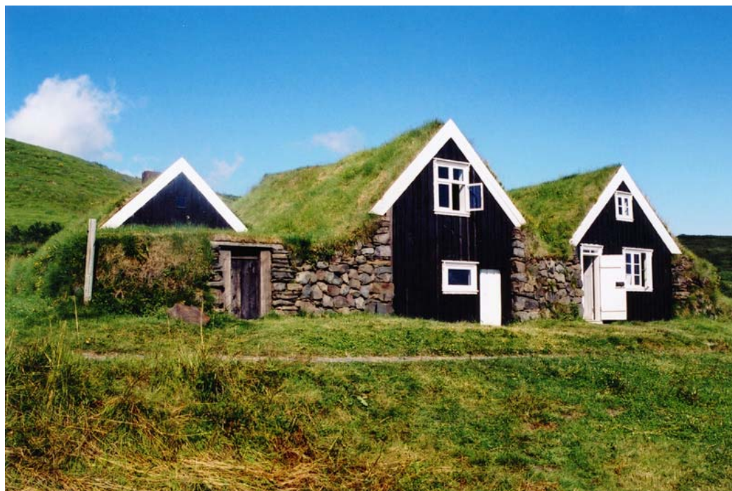
Mynd 8. Selið í Skaftafelli er einn af torfbæjunum í Húsasafni Þjóðminjasafnsins. Ljósmynd. Haraldur Helgason 2005.
