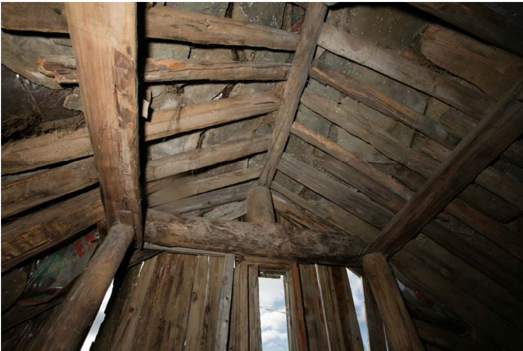
Mynd 11. Í þessari hlöðu á Núpsstað má sjá dæmi um fornt byggingarlag burðarvirkis. Ljósmynd af Brynjólfsson.
